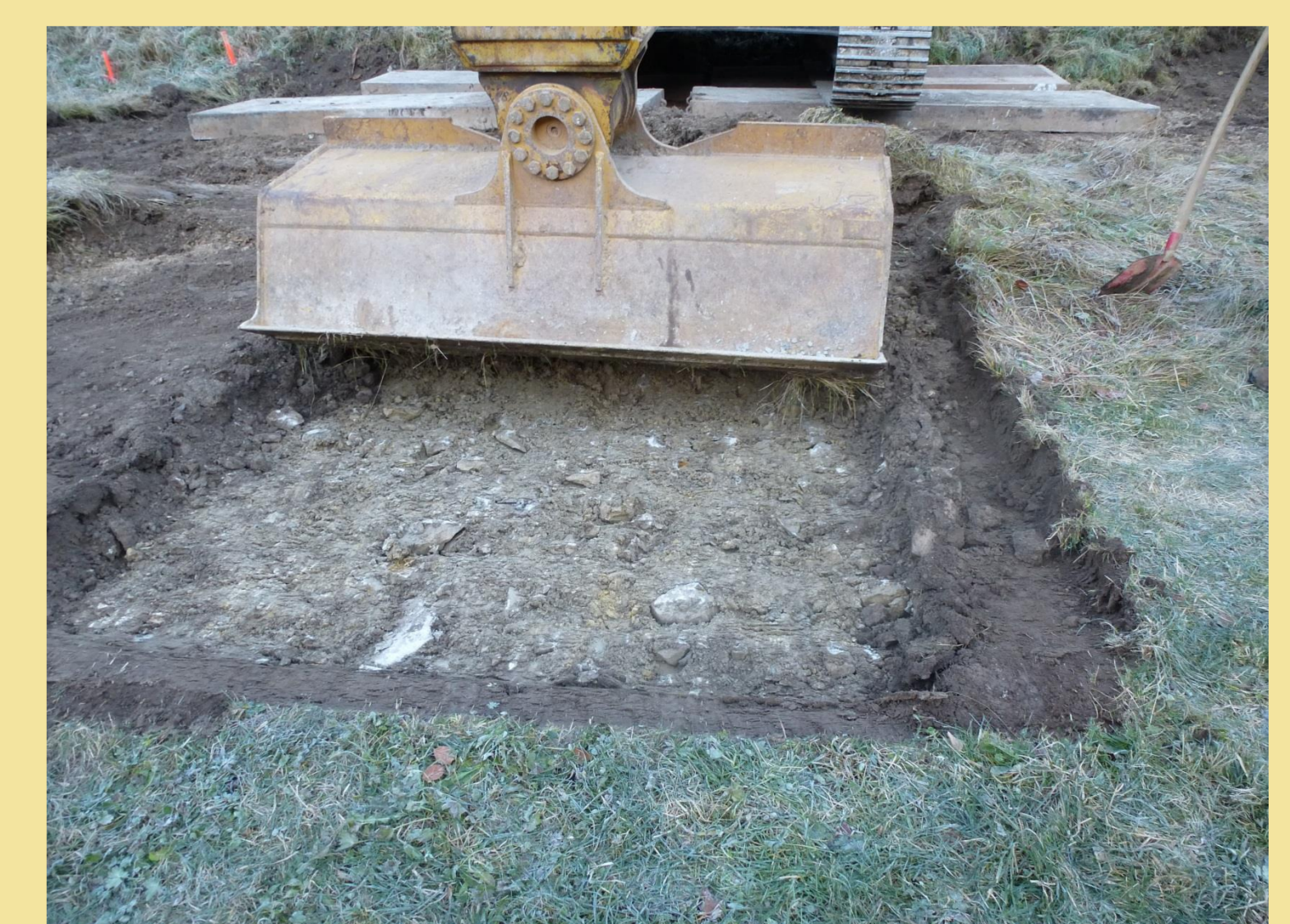
Abb. 7 und 8: Bodenabtrag vor Kopf von befestigten Flächen aus bzw. auf Baggermatrizen
