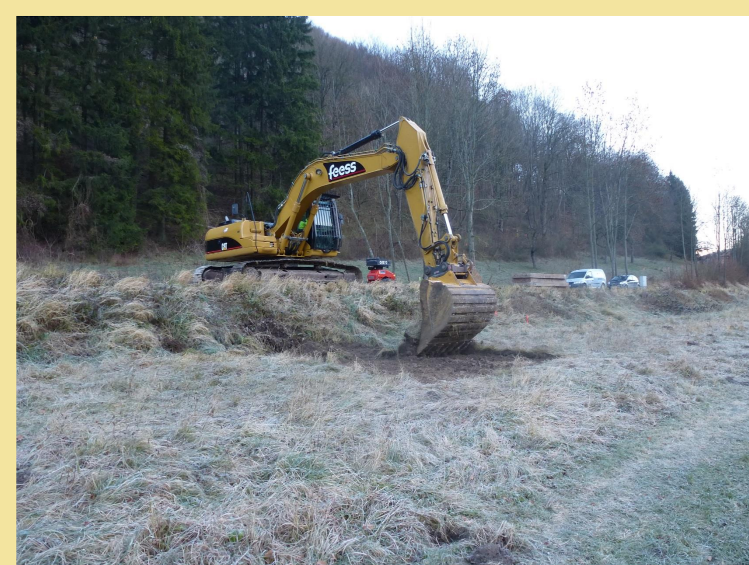
Abb. 7 und 8: Bodenabtrag vor Kopf von befestigten Flächen aus bzw. auf Baggermatrizen
