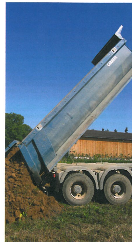
Verbringung des Oberbodenmaterials zur Auftragsfläche
